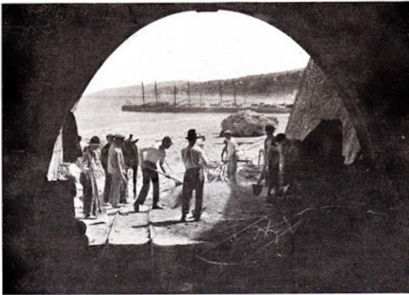
Sbocco della galleria nel porto di Rodi garganico.
