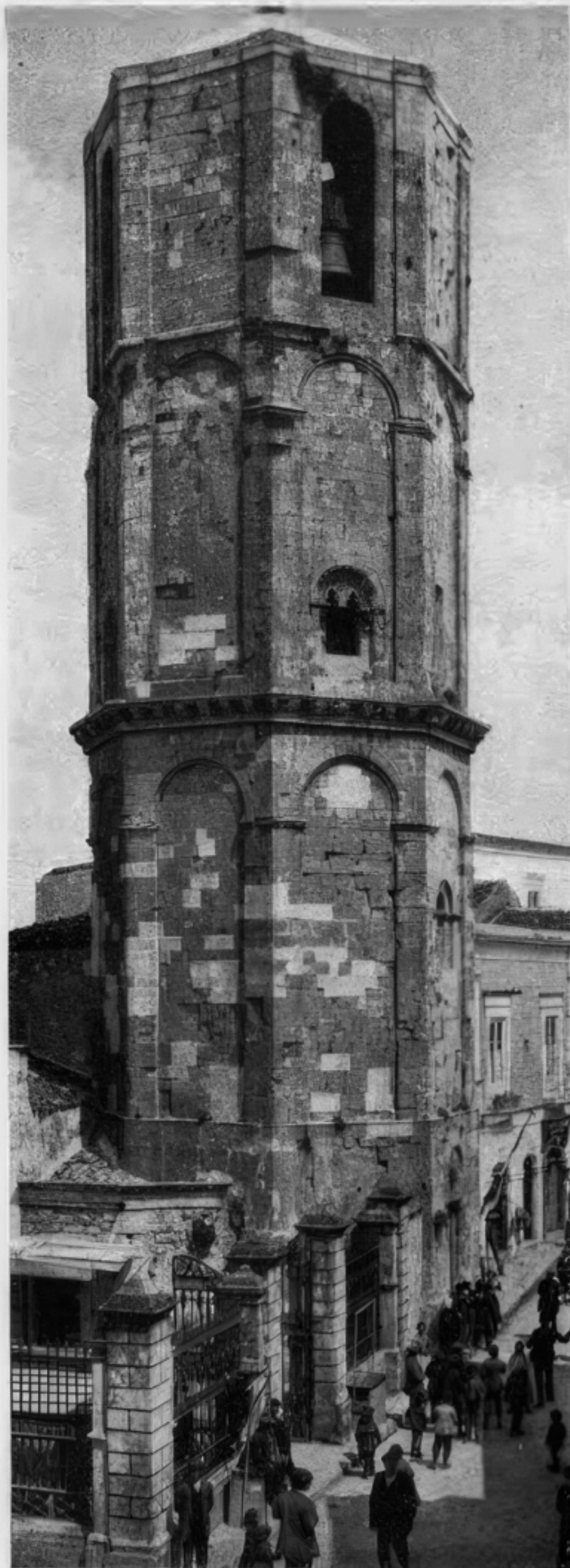
IL CAMPANILE ANGIOINO DELLA BASILICA DELL'ARCANGELO.
